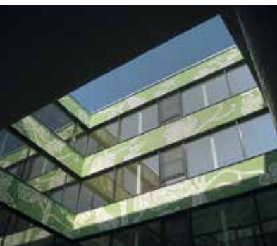
Fassade Weinlaub NÖ Pflege- und Betreuungszentrum Wolkersdorf
